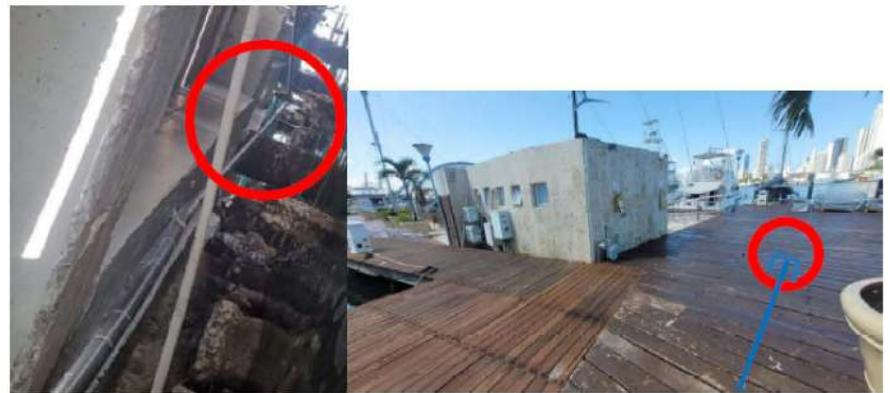
Ilustración 2. Tubería punto muerto con fuga en tapón
