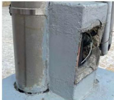
Corrosión galvánica en la base del mástil
